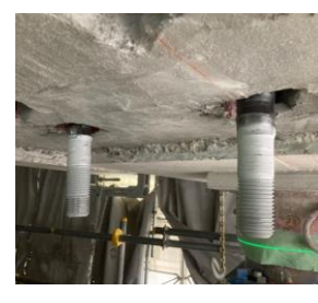
挿入後の固定状況-2
