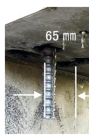
挿入後の固定状況-1
